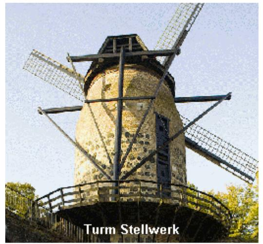
Auf der Oberkante des Mühlenturmes befindet sich ein hölzernes Rollenlager und darauf sitzt die Mühlenkappe. Das Drehen der Haube mit den Flügeln erfolgte früher über den Steert. Der senkrechte Steertbalken wird durch vier Verstreben abgestützt. An den zwei Querbalken, die waagrecht durch die Haube laufen (einer an der Hinterkante, der andere durch die Mitte), sind rechts und links Balken (Schwerter genannt), die unten am Steert angebracht sind.
